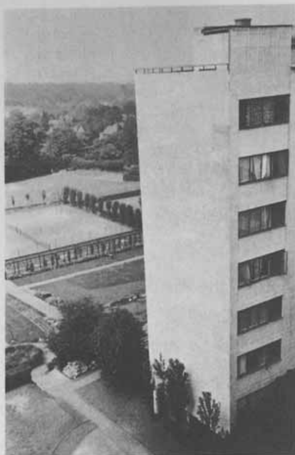
512. Edificio de viviendas en Highpoint, Londres, obra del grupo Tecton, 1936-1938. Hasta cierto punto similar a los bloques pastilla, este edificio, a una lujosa escala, representa al mismo tiempo una vuelta a la tradición inglesa de colocar grandes residencias dentro de unos extensos terrenos de recreo.
